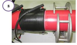
8. Зафиксируйте соединение неподвижно (желательно с использованием позиционера) и подключите сварочные кабели к контактам муфты.
