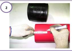
2. Используя линейку или муфту в качестве ориентира, отметьте на трубе границу зоны для зачистки. Для этого используйте специальный маркер.
