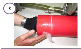
5. Осмотрите подготовленную поверхность и произведите обезжиривание зоны сварки с помощью специальной салфетки, пропитанной спиртом.
