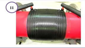
11. Индикаторы показывают, что сварка была произведена. Позиционер должен оставаться в работе до окончания полного времени охлаждения.
