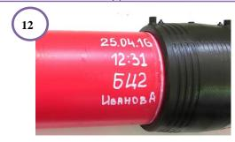
12. Снимите позиционер после охлаждения. Соединение выполнено. Промаркируйте его. Проведите визуальный контроль сварного соединения.
